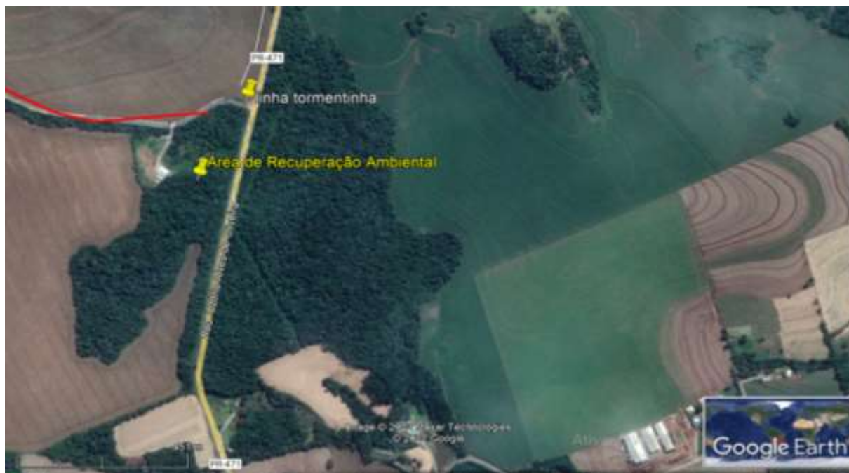
Figura 71. Localização da área recuperada de Catanduvás/PR, antigamente utilizada como local de disposição final de resíduos sólidos urbanos
