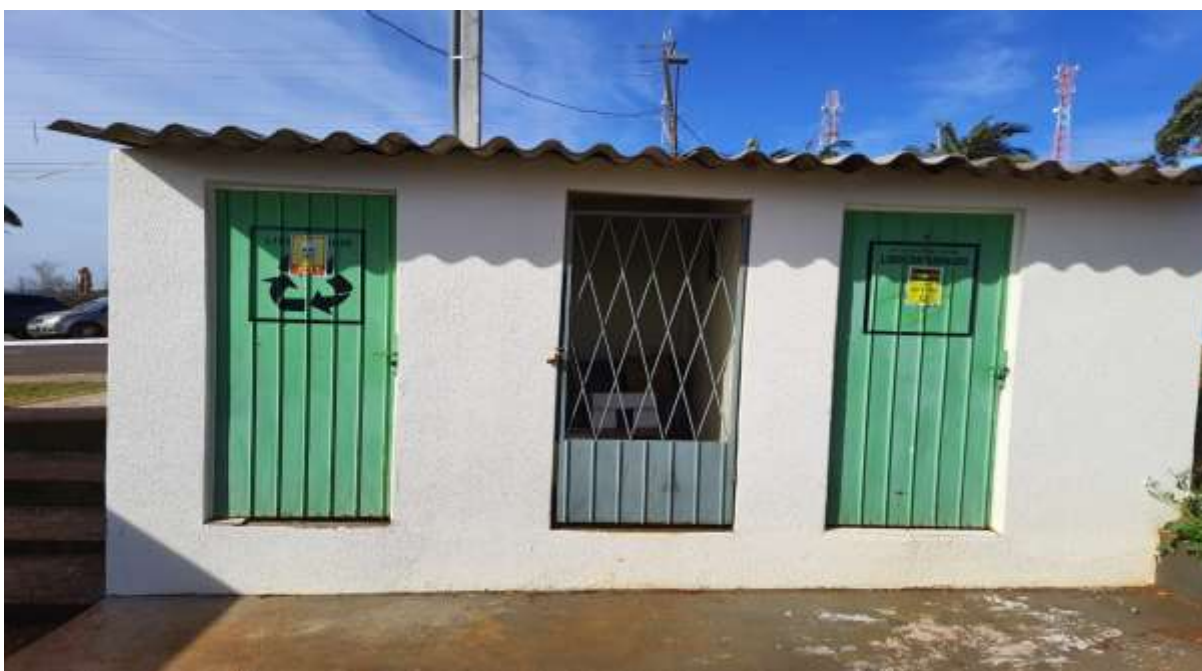
Figura 59. Edificação específica de armazenamento temporário de resíduos dos serviços de saúde do Pronto de atendimento Municipal de Catanduvás/PR
