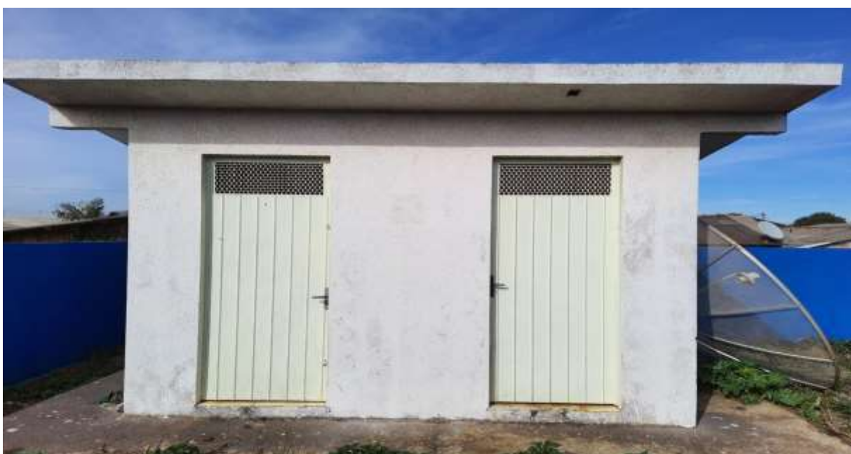
Figura 53. Edificação específica de armazenamento temporário de resíduos dos serviços de saúde da UBS Alto Alegre do município de Catanduvás/PR
