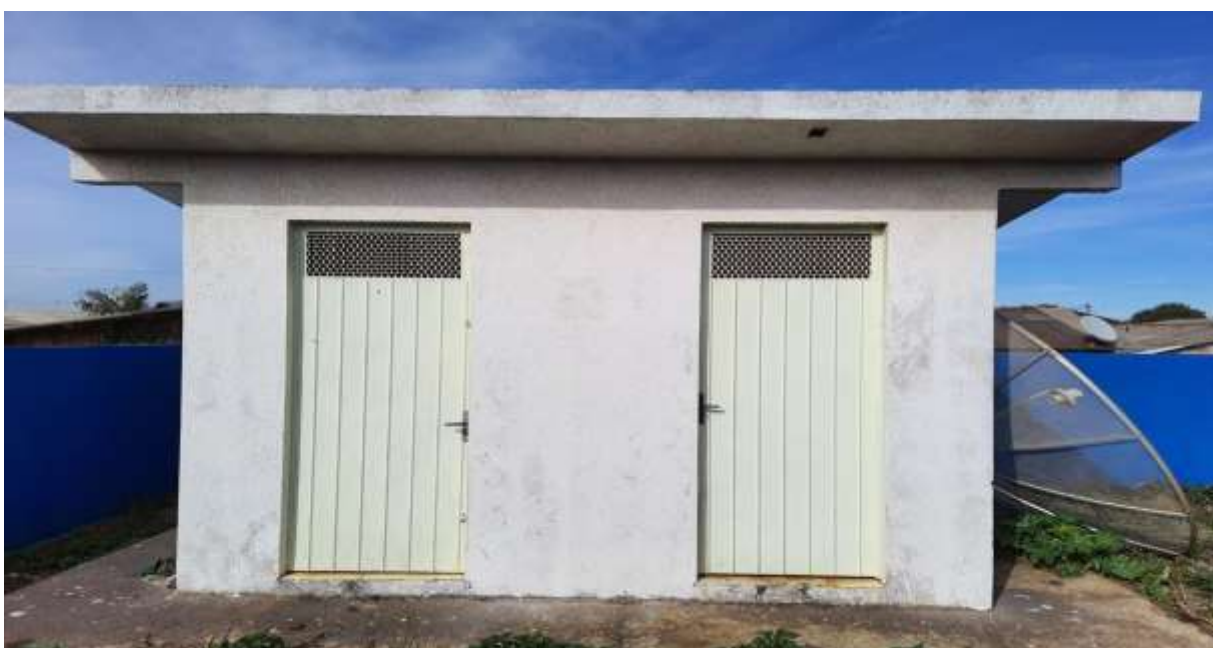
Figura 53. Edificação específica de armazenamento temporário de resíduos dos serviços de saúde da UBS Alto Alegre do município de Catanduvas/PR
