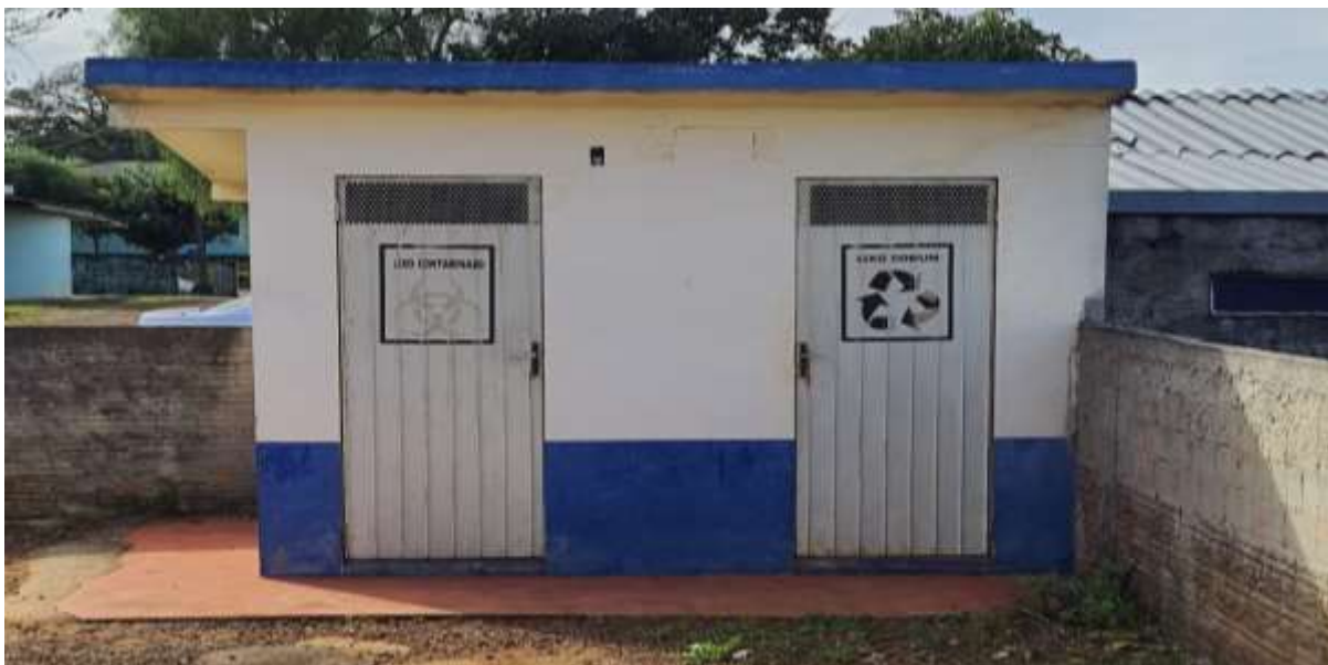
Figura 54. Edificação específica de armazenamento temporário de resíduos dos serviços de saúde da Unidade de Saúde Central de Catanduvás
